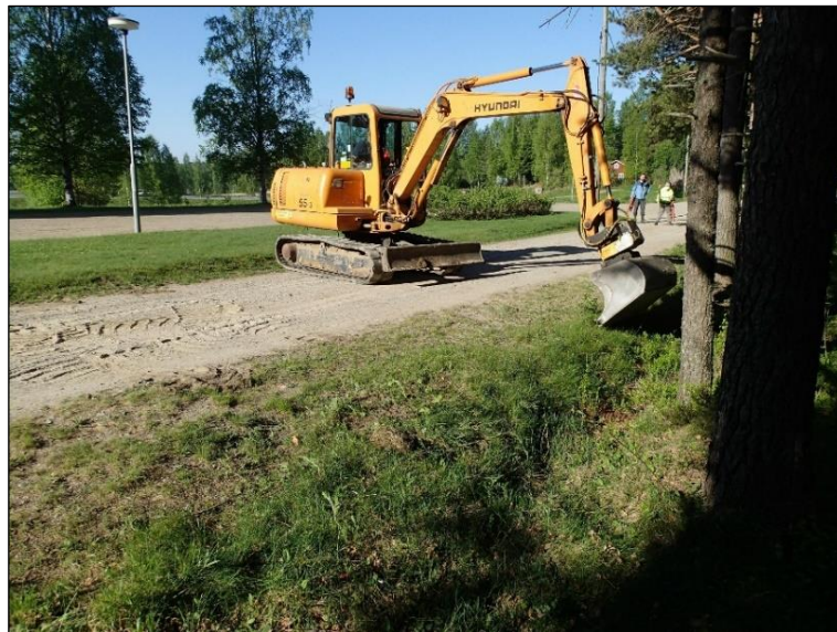
Koeojan kaivaminen aluillaan. Lounaaseen.
