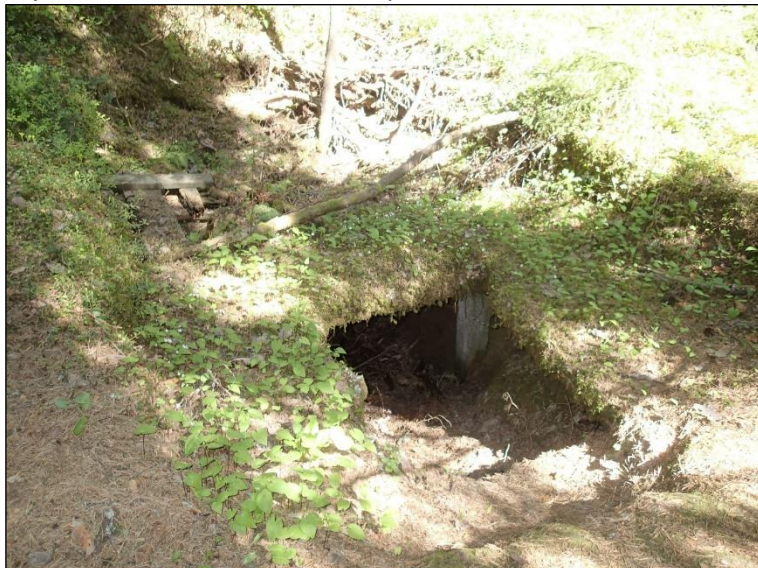
Alla: Rinnevarjostuskuvaan s. 22 keltaisella pisteellä merkattu betonirakenteinen kellari.
